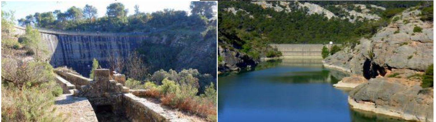
Autre vue du canal et du barrage de Zola
